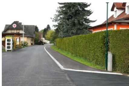
Die neu asphaltierte Rotkreuzstraße in Ilz.
