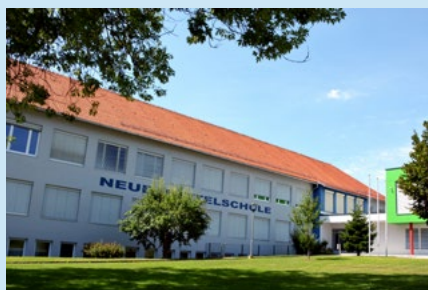
Die NMS wird mit einem behindertengerechten WC ausgestattet.
